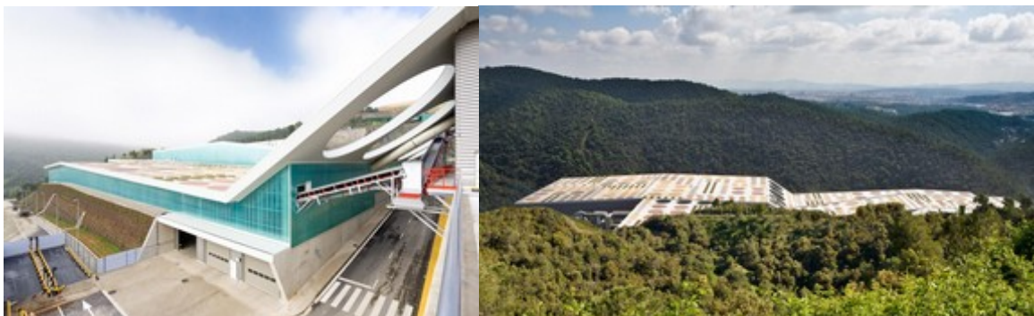
Figura 2. Centro de Tratamiento de Residuos de Vallés Occidental (CTR)
