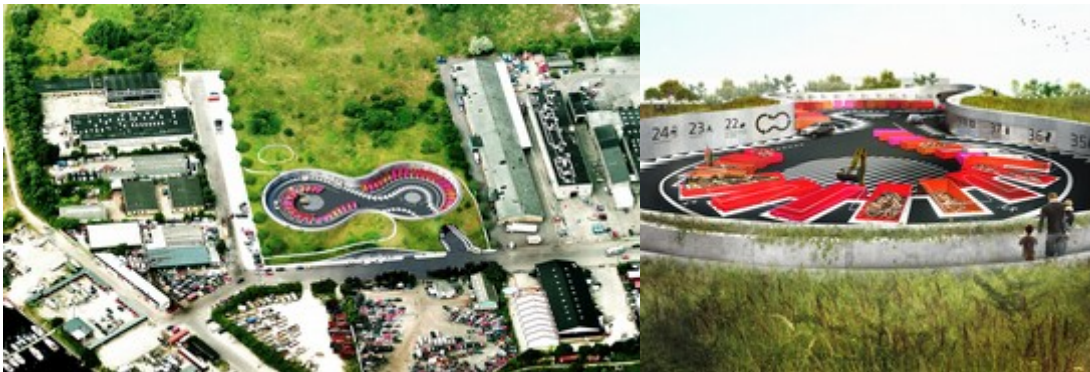
Figura 3. Centro de reciclaje Sydhavns
