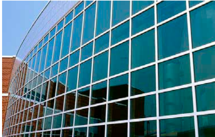
Figura 97 - Muro cortina. Fuente: http://img.archiexpo.es/images_ae/photo-g/51651-2134979.jpg . (2016)
