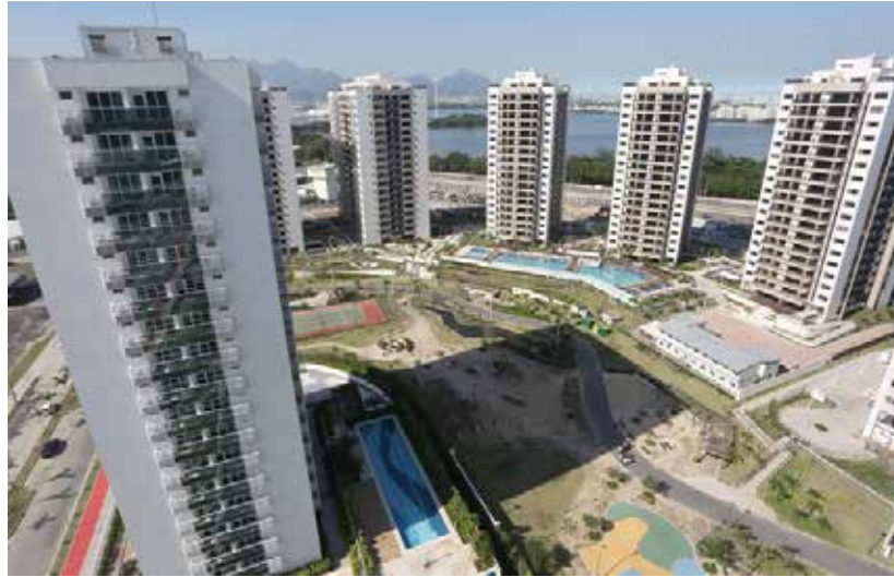
Figura 2: Villa Olímpica Rio (2016)
