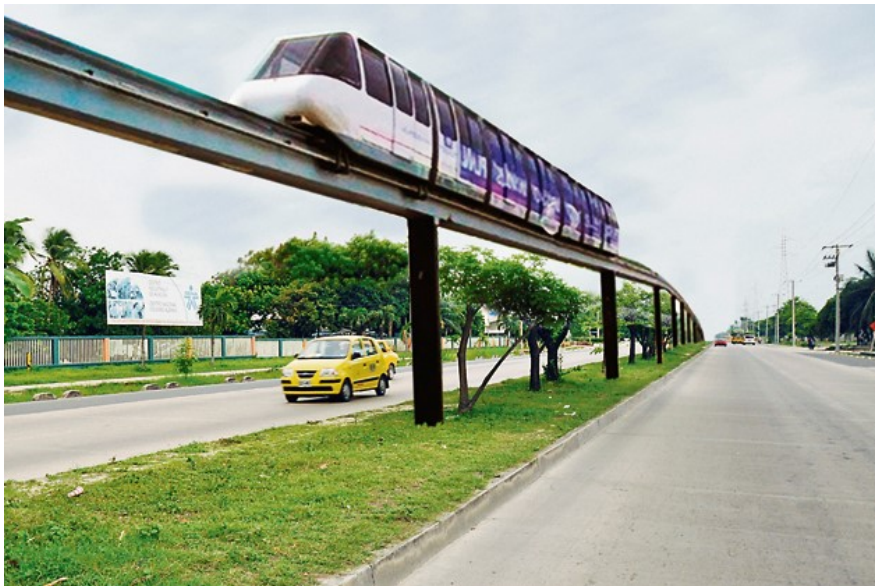
Figura 25: vía de Monorriel
