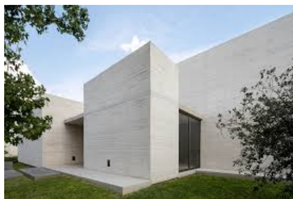
Figura 13. Área de las ventanas y ventanales se utilizó junta de silicón.
