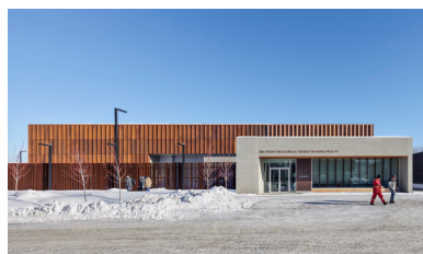
Figura 3: Centro de entrenamiento de oficios mecánicos pesados CNC.
