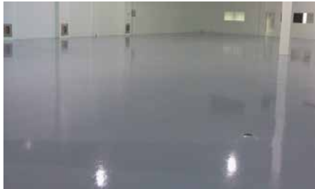
Figura 46: Suelo epóxico. Fuente: www.aplikamolina.com (2016)
