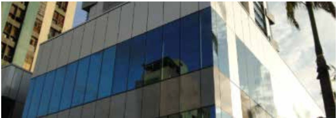
Figura 43: Junta Negativa. Fuente: http://instalacionesulpino.com.ve (2016)
