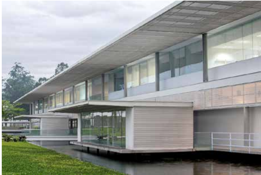
Figura 2. Fábrica de tintas y sistema de seguridad. Fuente:
