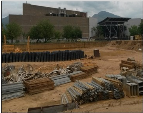
Ampliación Centro Comercial Sambil Municipio Naguanagua
