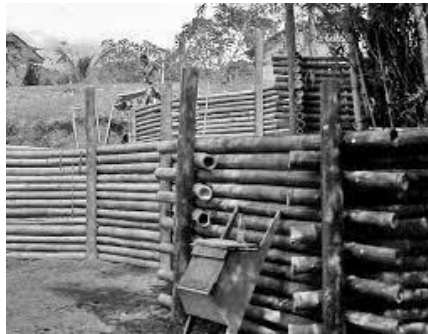
Figura 24 Muro a dos niveles con Guaduas rollizas entrelazadas. Fuente: https://dialnet.unirioja.es
