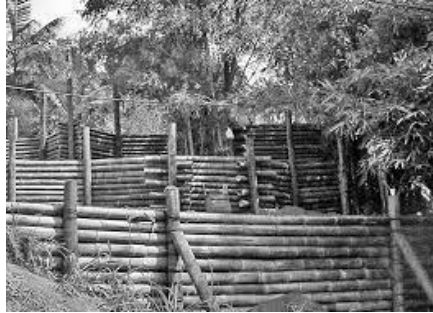
Figura 26 Muro de Guadua a tres niveles, soportados por postes y arriostres de madera.
