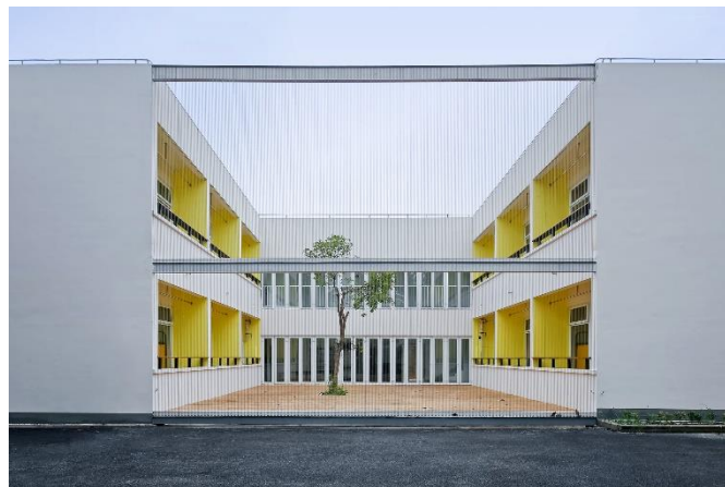
Figura 5: Fachada principal de residencias estudiantiles, Odense, Dinamarca
