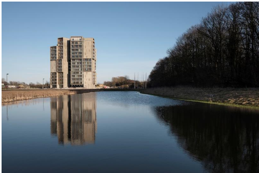
Figura 4: Fachada principal de residencias estudiantiles, Odense, Dinamarca
