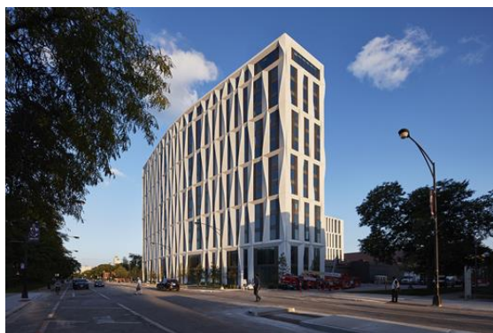
Figura 3: Fachada principal de residencias estudiantiles, Chicago, Estados Unidos.
