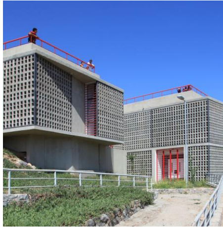
Figura 4. Fachada de Sede Social Comunitaria. [Revista de Arquitectura] Fuente: Arch Daily Alberto Castex
