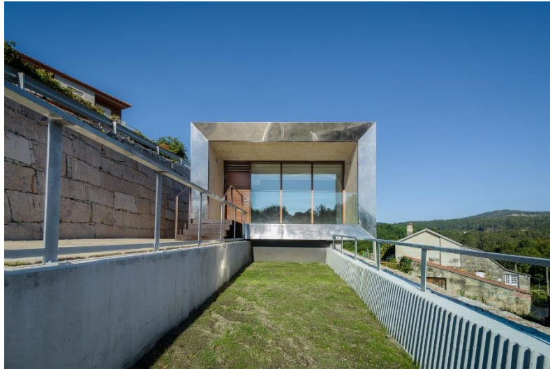
Figura 5. Fachada principal de Centro Social Cacheiro. [Revista de Arquitectura]
