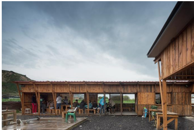
Figura 3. Cocina comunitaria de Terras da Costa. [Revista de Arquitectura] Fuente: Arch Daily Fernando Guerra
