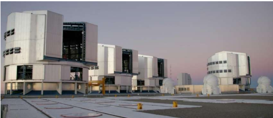
Figura 12. Observatorio Paranal, Vista Exterior Fuente: Rivi (2005)
