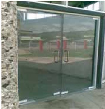
Figura 72. Puerta de Vidrio. (2017)
