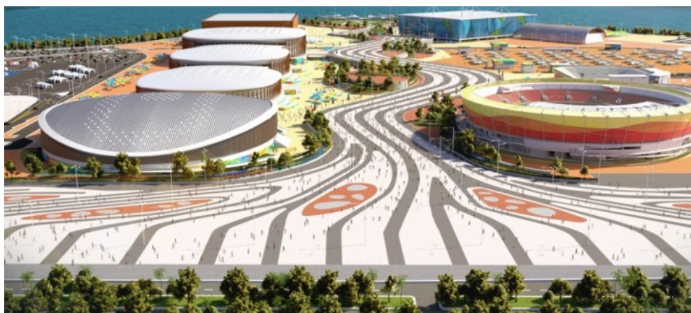
Fig. 32 Acabados de pisos. Fuente:
