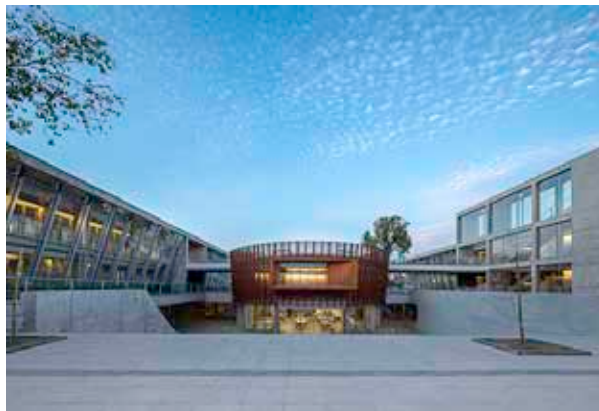
Figura 1: Fachada principal del Centro Consistorial de la comuna de Pedro Aguirre Cerda Fuente: www.plataformaarquitectura.cl. (2018)
