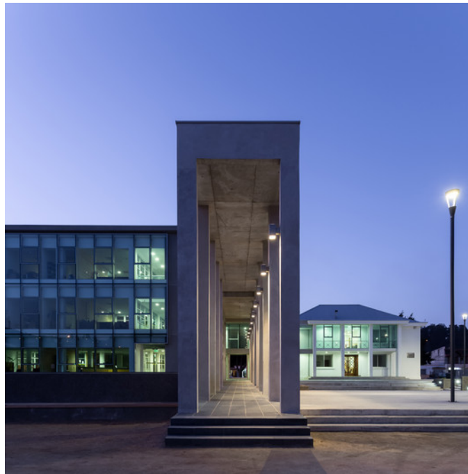
Figura 4: Vista del Edificio Consistorial de Constitución
