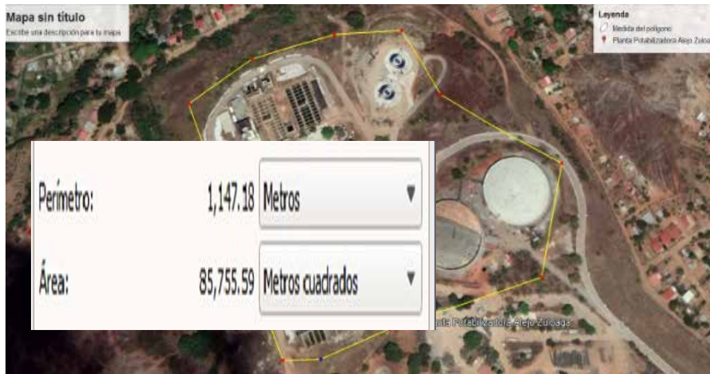
Figura 12. Área Planta de Tratamiento Alejo Zuloaga, Valencia, Estado Carabobo.
