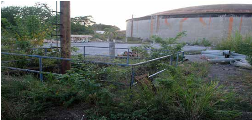
Figura 13. Estación Planta de Tratamiento Alejo Zuloaga, Valencia, Estado Carabobo.
