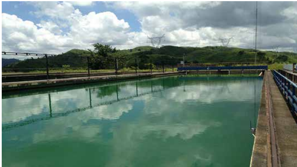
Figura 15. Aeraciones en la Planta de Tratamiento Alejo Zuloaga, Valencia, Estado Carabobo.
