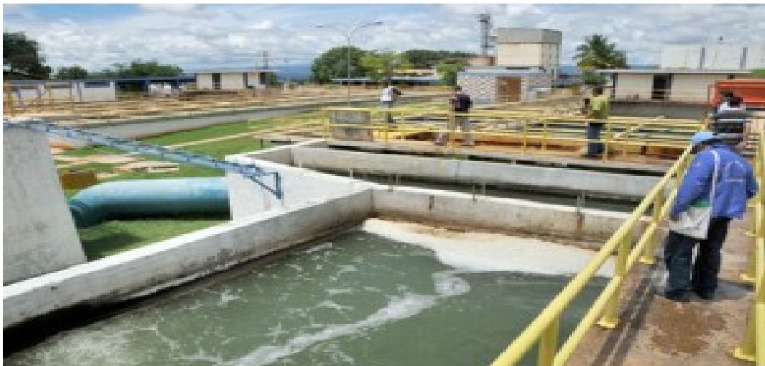
Figura 19. Obra de Llegada Planta de Tratamiento Alejo Zuloaga, Valencia, Estado Carabobo.
