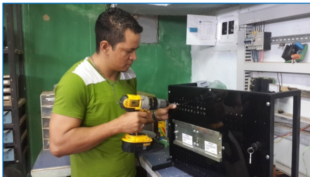
Figura 63: Construcción del banco de prueba.
