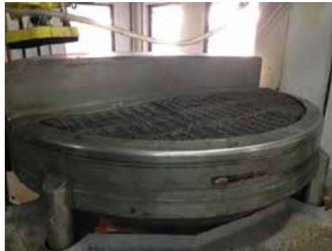
Foto N°1 Tolva de Recepción
