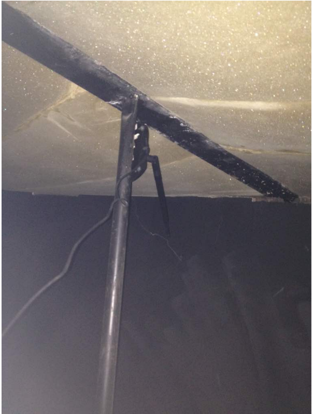
Figura 29. Ubicación de la antena del Access point actual Edimax.
