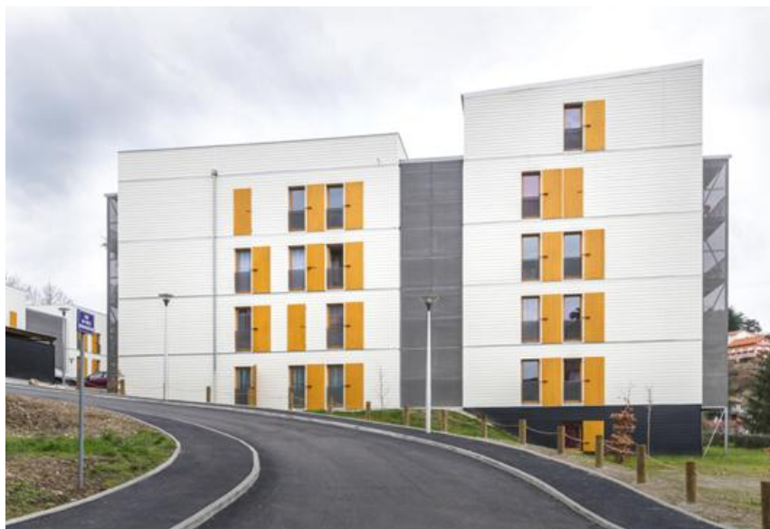
Figura Complejo de 60 unidades de vivienda [Imagen] Recuperado de
