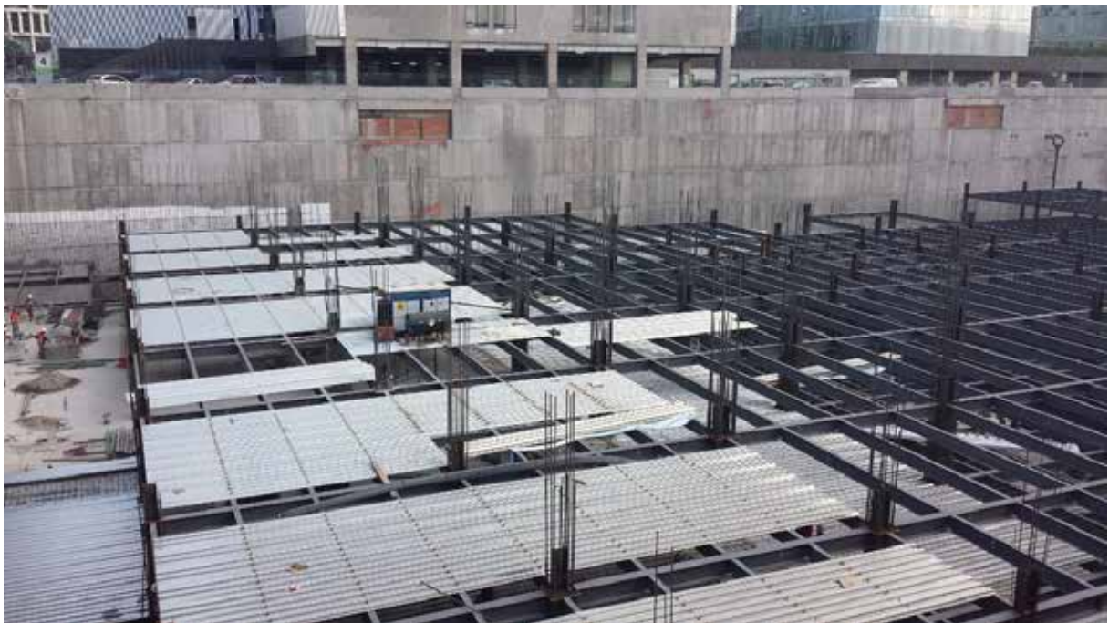
Figura 48: Instalación de la losacero. Valencia, Carabobo. Fuente: https://www.google.co.ve/search?q=que+es+la+losacero&source=lnms&tbn=isch&sa=X&ved=0ahUKEwio-... (2015)
