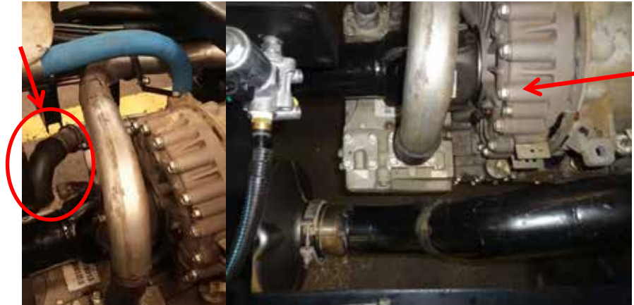
Figura 48. Reubicación de la ruta de la tubería de tránsito de refrigerante de la transmisión a fin de disminuir la transferencia de calor a ésta por las altas temperaturas que se pueden desarrollar en el convertidor catalítico.
