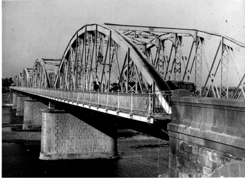
Figura 11 Puente de metal y concreto
