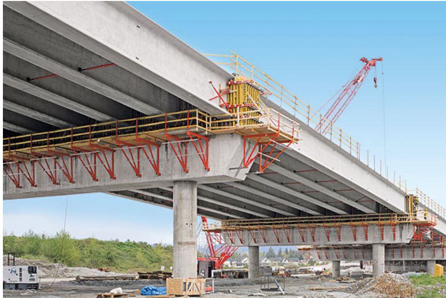
Figura 13 Puente concreto armado
