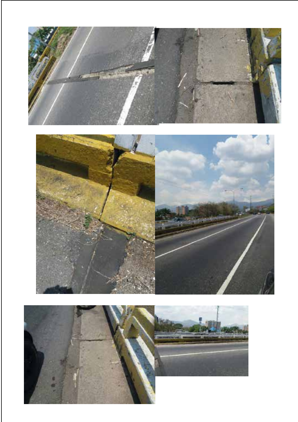
ANEXO 3 Reporte Fotográfico 3, juntas y barreras de distribuidor de Mañongo
