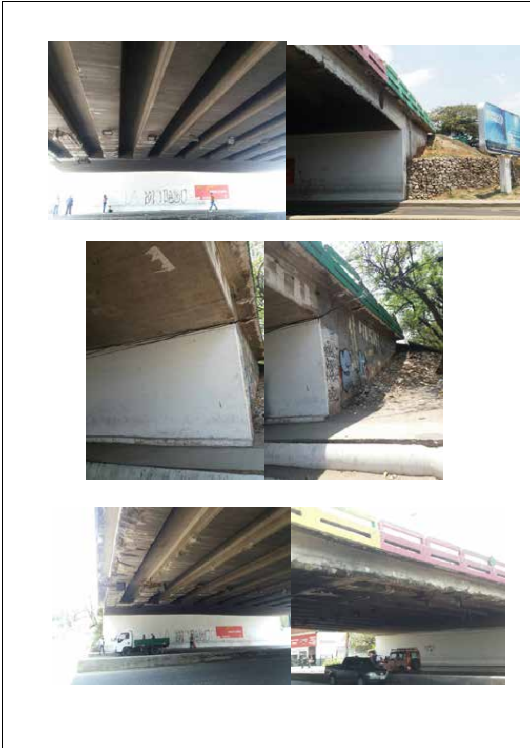
ANEXO 4 Reporte Fotográfico 4, vigas, taludes, estribos y calzada de distribuidor Michelena
