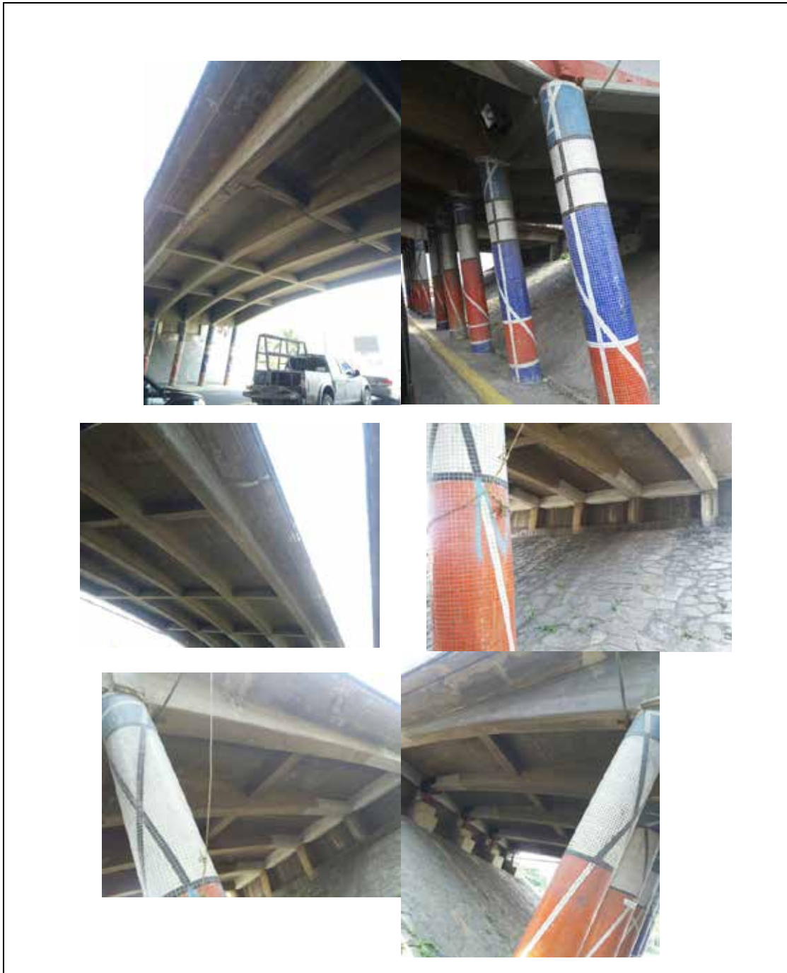
ANEXO 1 Reporte fotográfico 1, vigas, tableros y pilares de distribuidor Mañongo
