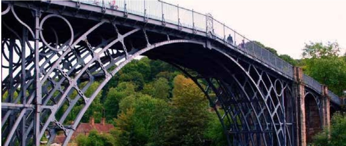
Figura 12 Puente hierro fundido
