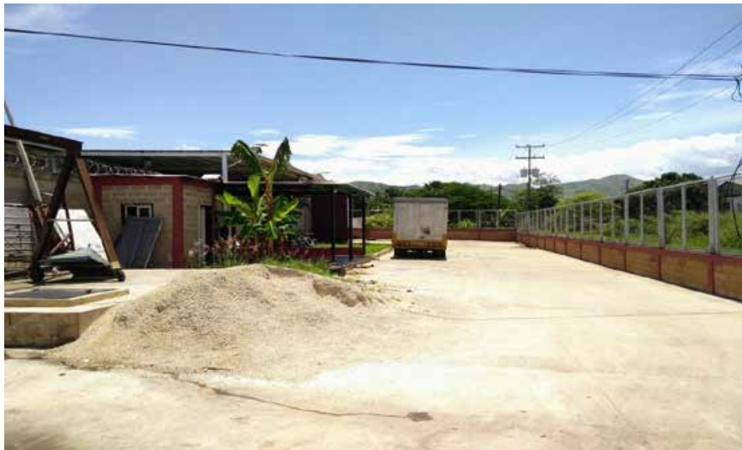
Figura 26: Área disponible para instalación del tanque de combustible Fuente: Empresa Visiservice C.A
