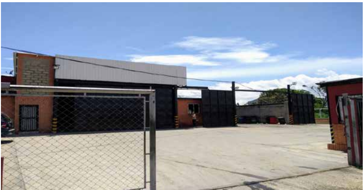
Figura 18: Instalaciones externas Fuente: Empresa Visiservice C.A
