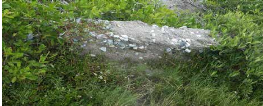
Figura27 Excedentes de agua sin canal
