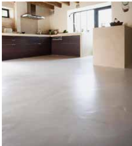
Figura 57. Acabado de piso en cemento pulido. Fuente: http://www.mineralrevest.com/microcemento-alisado/ (2018)
