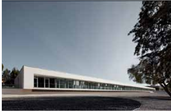
Figura 1: Vista de Fachadas. Fuente: http://www.plataformaarquitectura.cl/cl/02-366965/centro-de-rehabilitacion-psicosocial-otxotorena-arquitectos (2014).
