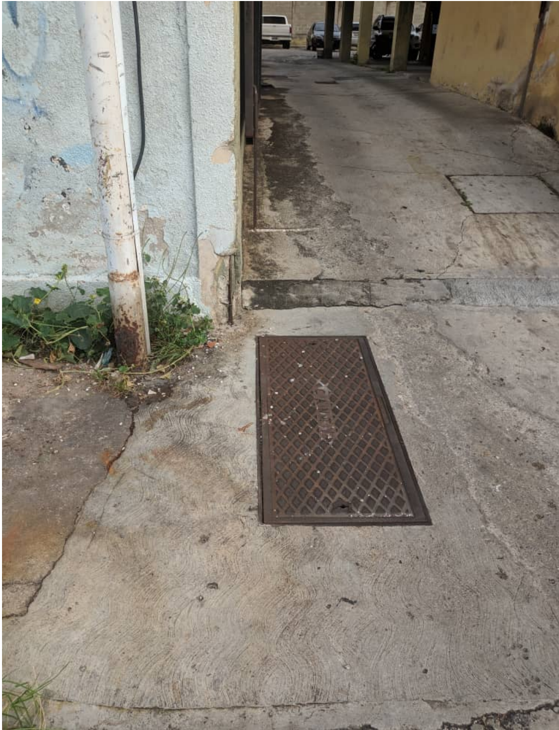
Figura 33: Alcantarilla que canaliza la línea de cobre de CANTV
