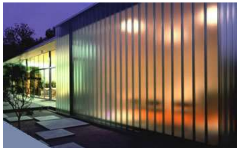
Figura 29: Vidrio con perfiles auto portantes.
