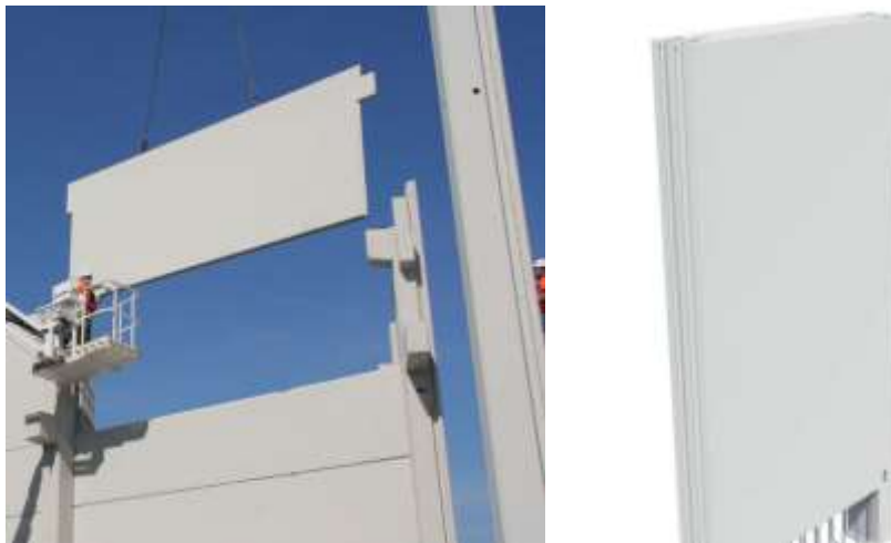
Figura 30: revestimiento de fachada de hormigón prefabricado
