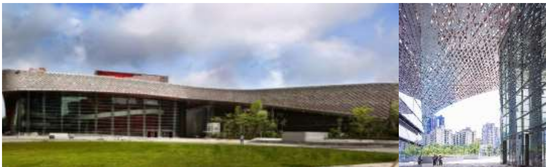
Figura 4: vista central, y fachada
