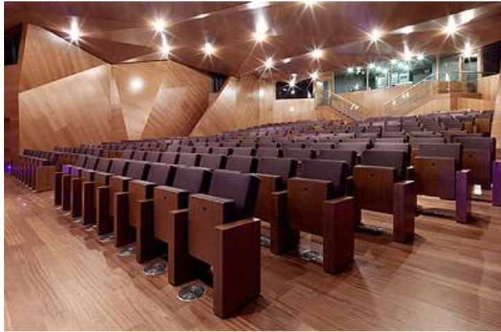
Figura 37: revestimiento de madera de aislamiento acustico del auditorio
