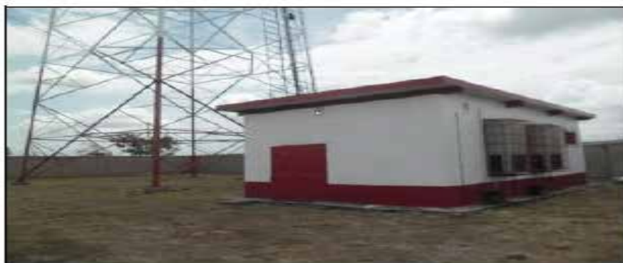
Figura 20. Caseta de telecomunicaciones de la estación Chorore.
