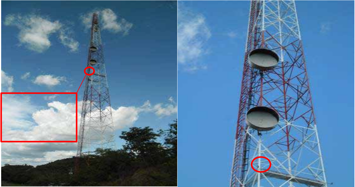
Figura 37. Ubicación de la antena en la torre autoportada de N53 con vista a Potrerito.
