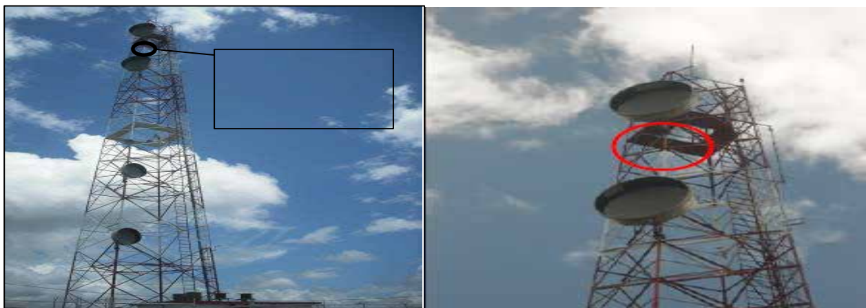
Figura 36. Ubicación de la antena en la torre autosoportada.
