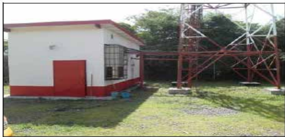
Figura 22. Caseta de telecomunicaciones de la estación El Chivo.
