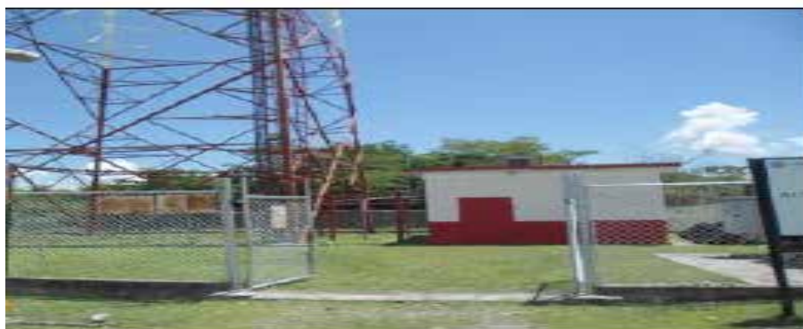
Figura 18. Vista de la gaceta de telecomunicaciones de la estación N53.
