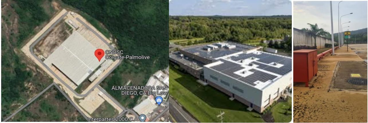
Figura 16: Paneles solares y distribuidor de electricidad Autor: Devia y Fung año 2023
