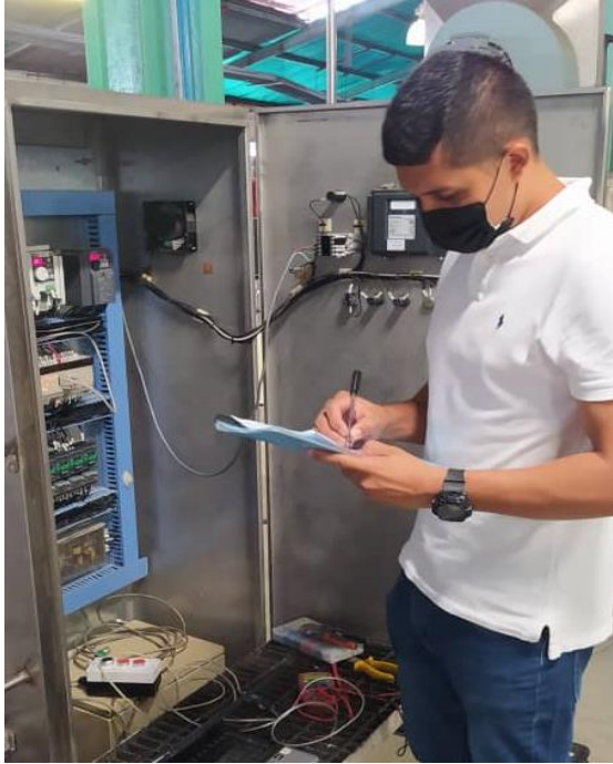
Figura 16. Levantamiento de conexiones.
