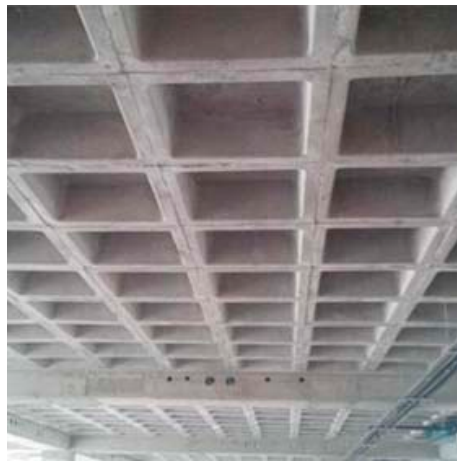
Figura 23: Losa Nervada construida.
