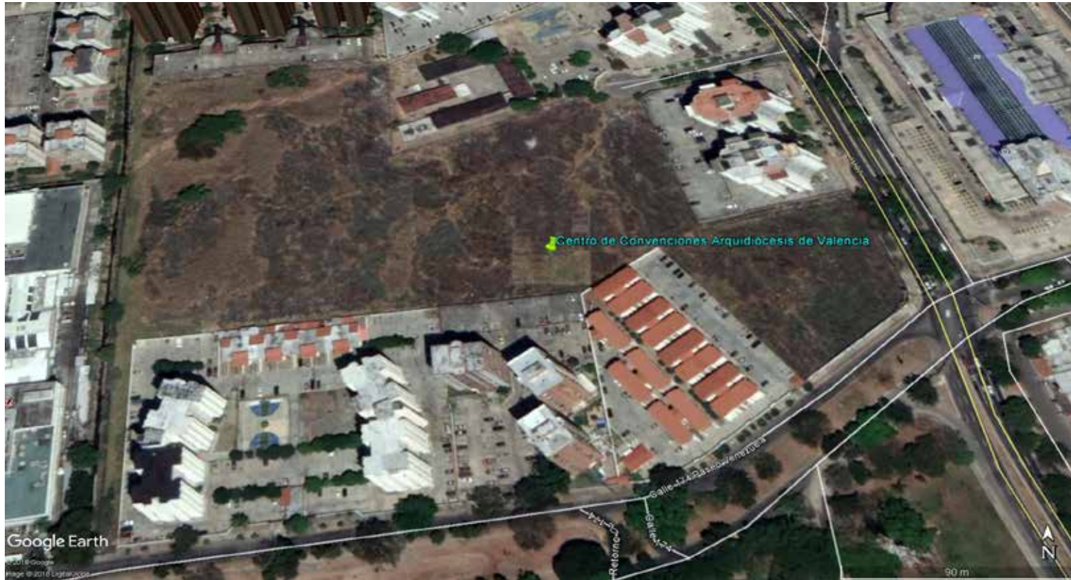
Figura 8 Apreciación visual de la obra civil inconclusa Fuente Google Earth Pro.
