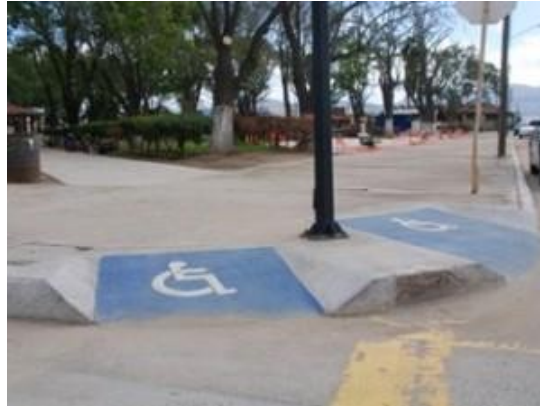
Figura 25: Rampas de acceso a aceras. (2017)
