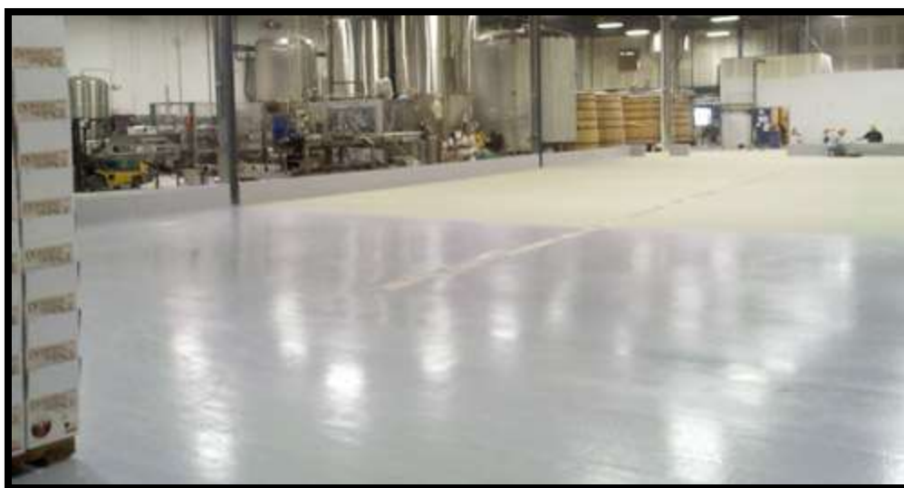
Figura 13. Acabado de piso (Floro Shop).
