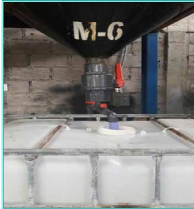
Figura 34. Descarga del suavizante del mezclador al baritanque.
