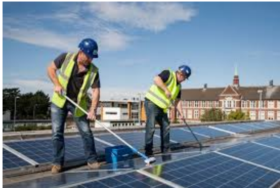
Figura 26. Mantenimiento y limpieza de paneles fotovoltaicos. Fuente: https://energiasolarfotovoltaica.org/limpieza-y-mantenimiento-de-paneles-solares/
