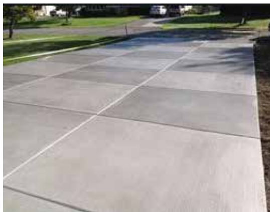
Figura 28. Concreto Escobillado. Fuente: Sosa (2020)
