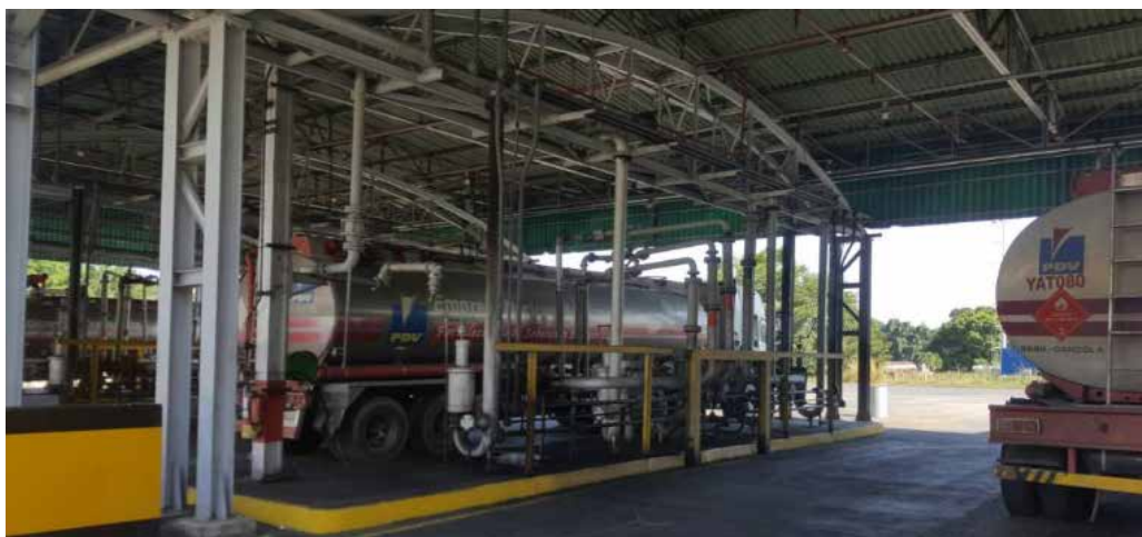
Figura 13: Proceso de llenado de las gandolas cisternas Fuente: Planta Distribuidora PDVSA Yagua. (2018)
