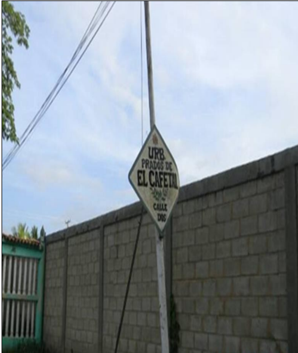
Figura 17. Entrada Principal del Urbanismo.
