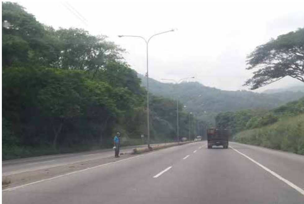
Figura 09: Defensa central en autopista Valencia-Puerto Cabello
