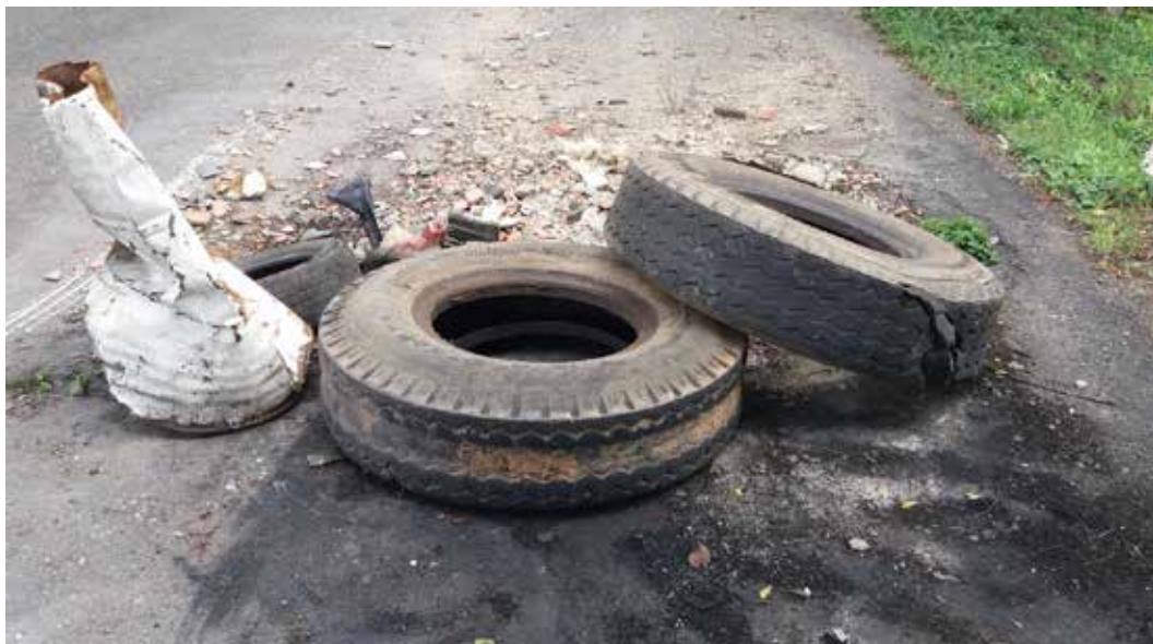
Figura 06: Fallas en el pavimento sobre troncal 11 en tramo de Carabobo
