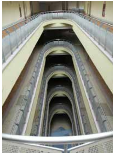
Figura 4.3. Fotografía de abertura en el tramo central del Módulo en todos los niveles.
