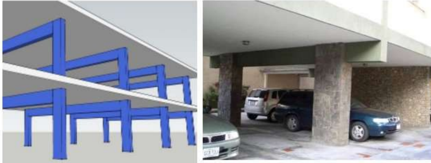
Figura 2.8. Ausencia de vigas altas.
