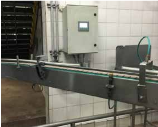
Figura 44. Zona de la línea 02 DH 115 donde se pretende colocar el checkweigher. Fuente: La autora (2021).
