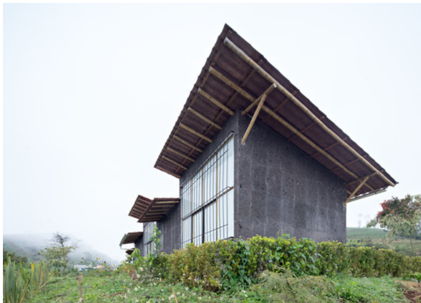
Figura 4. Vista del Centro de producción de orgánicos Chilsec.
