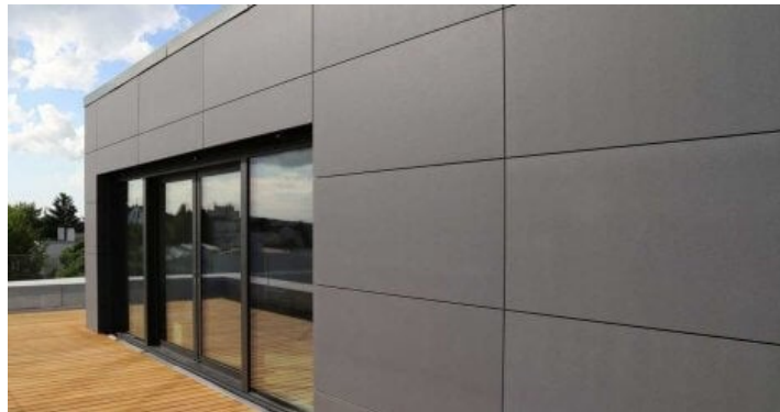
Figura 19: Aplicación de Placas de Fibrocemento en fachadas.
