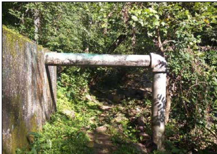
Figura 8. Desarenador con tubería de Rebose. Fuente: Azuaje, Nuñez (2020)
