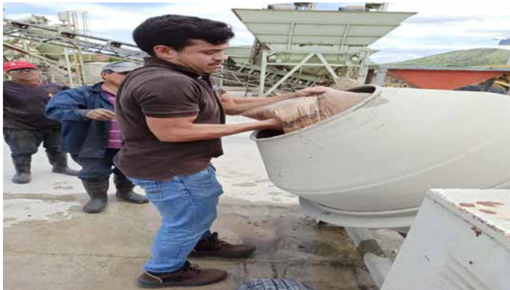
Figura 25. Mezclado con trompo.
