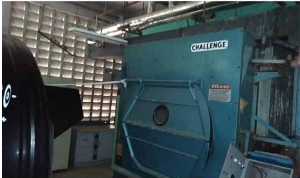
Figura 2. Estado actual de la lavandería.
