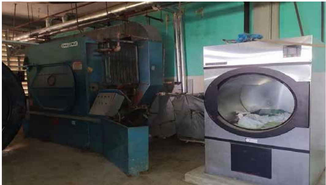
Figura 4. Estado actual de la lavandería
