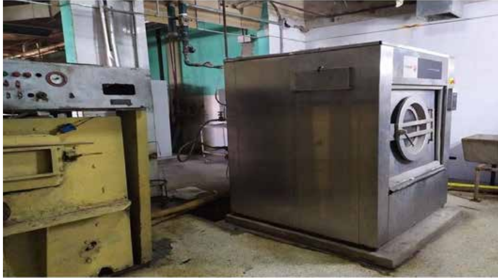
Figura 1. Estado actual de la lavandería
