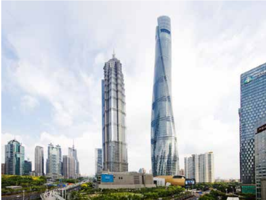
Figura 3. Torre Shangai en la ciudad de Shangai. Fuente: WIKIPEDIA(2019).
