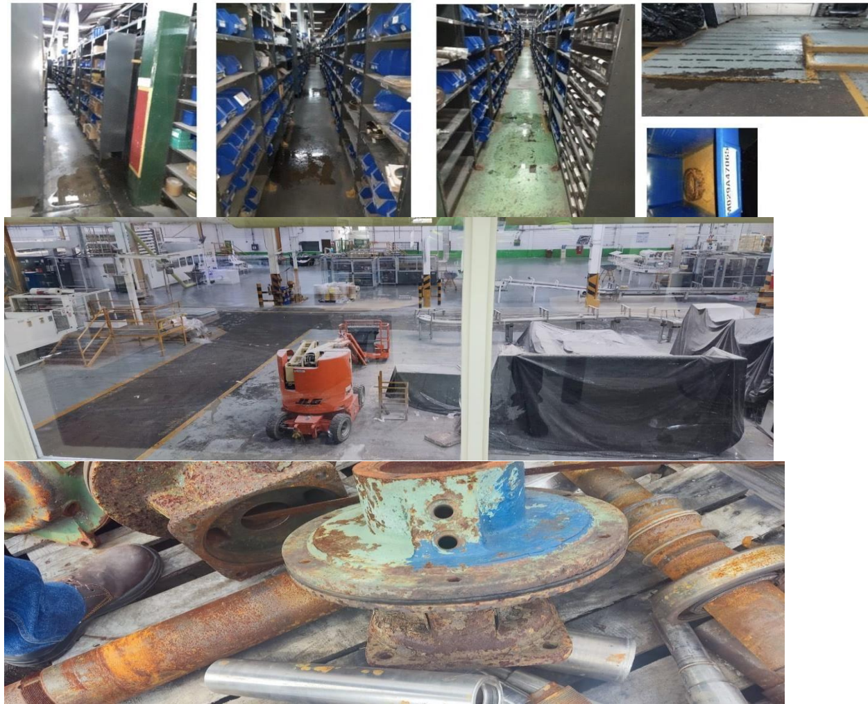
Figura 1. Estado actual del almacén de repuestos
