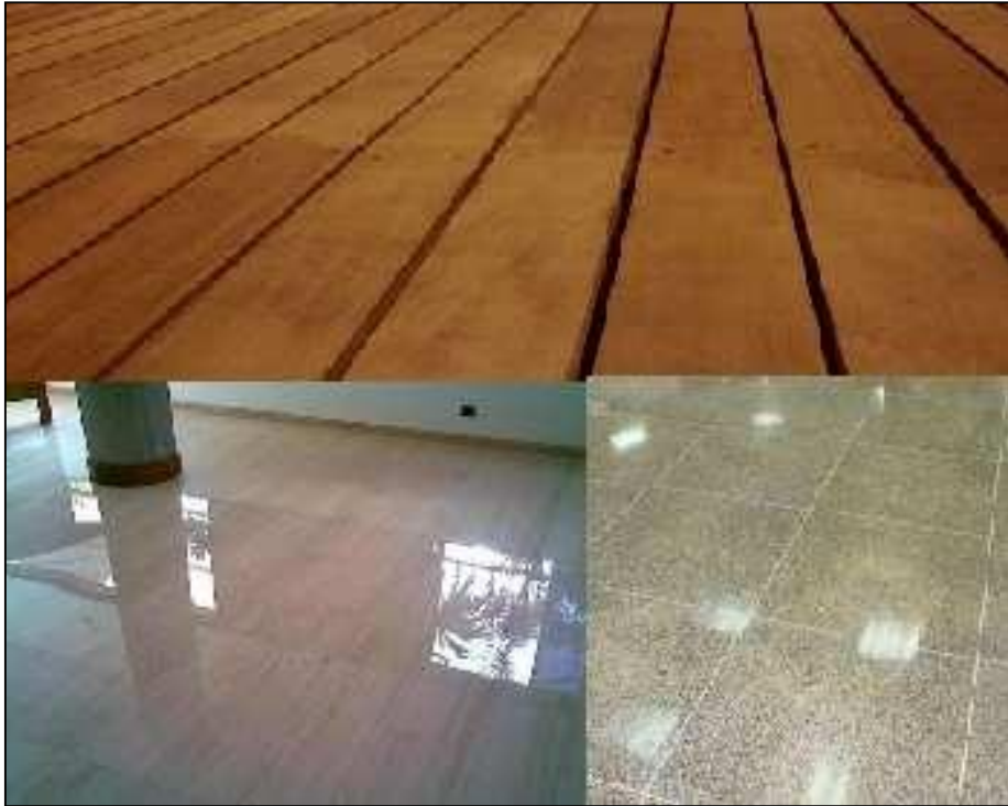
Figura 21: Acabados de piso en espacios públicos. (2021)
