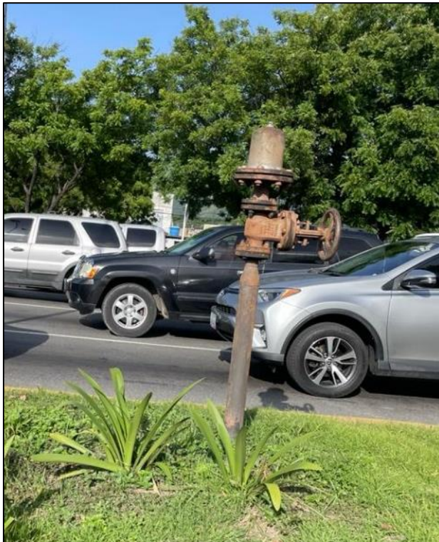
Figura 26: Ventosa y llave de paso, imagen 4.
