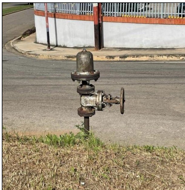
Figura 24: Ventosa y llave de paso, imagen 2.
