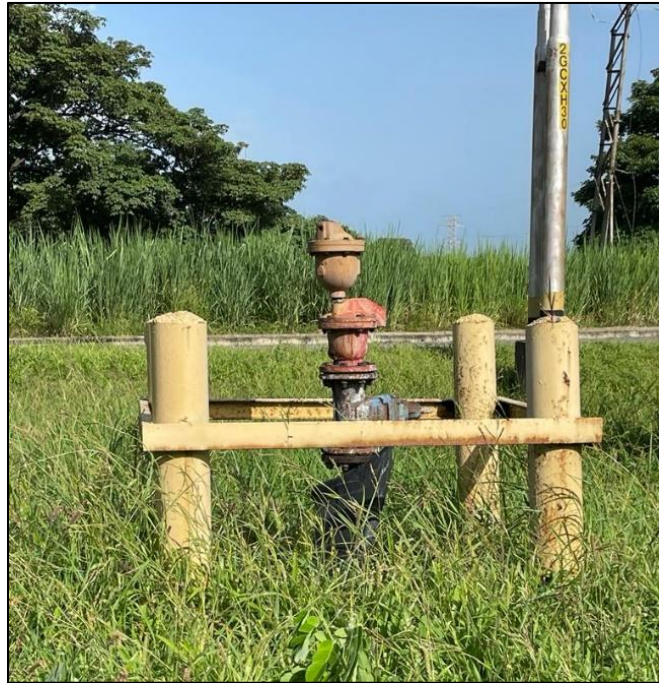
Figura 24: Ventosa y llave de paso, imagen 2.
