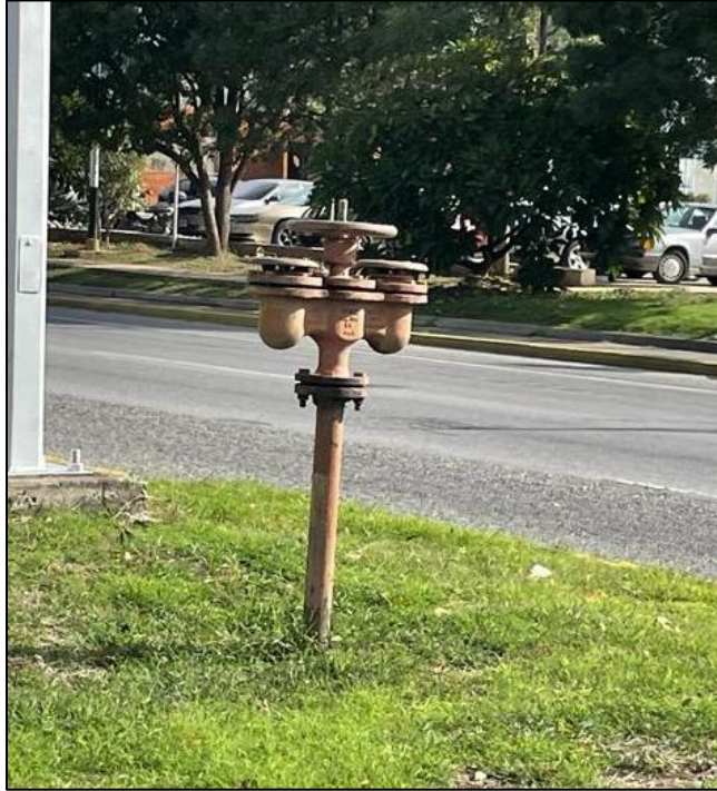
Figura 26: Ventosa y llave de paso, imagen 4.
